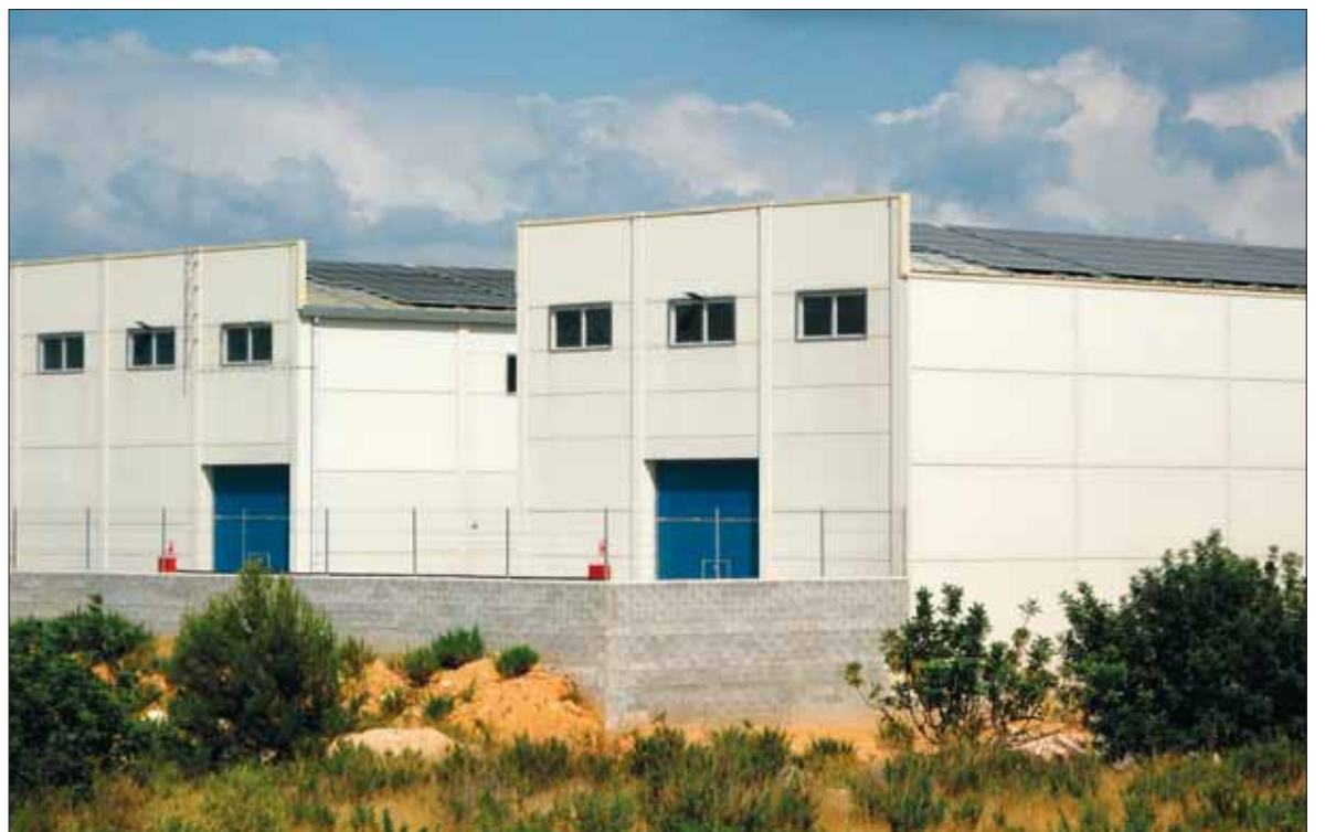
Les noves instal·lacions de Frupinsa al Catalunya Sud.
